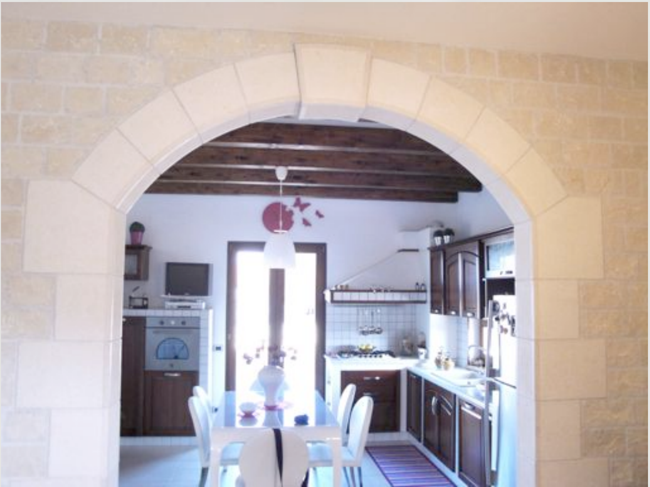
Arco di collegamento fra due stanze eseguito con blocchi massicci lavorati a mano; il resto della parete è stato rivestito con marmette lavorate a spacco di cava. Sotto a destra particolare della chiave di volta.
