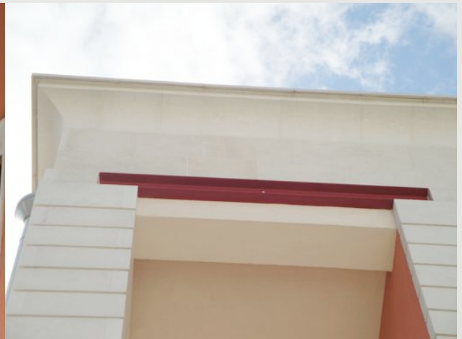
A sinistra pilastri rivestiti con blocchi levigati in cui è stata ricavata una zona d'ombra; il pavimento è stato realizzato con lastre invecchiate. Sopra particolare del cornicione che dà sulla terrazza dello stabile.
