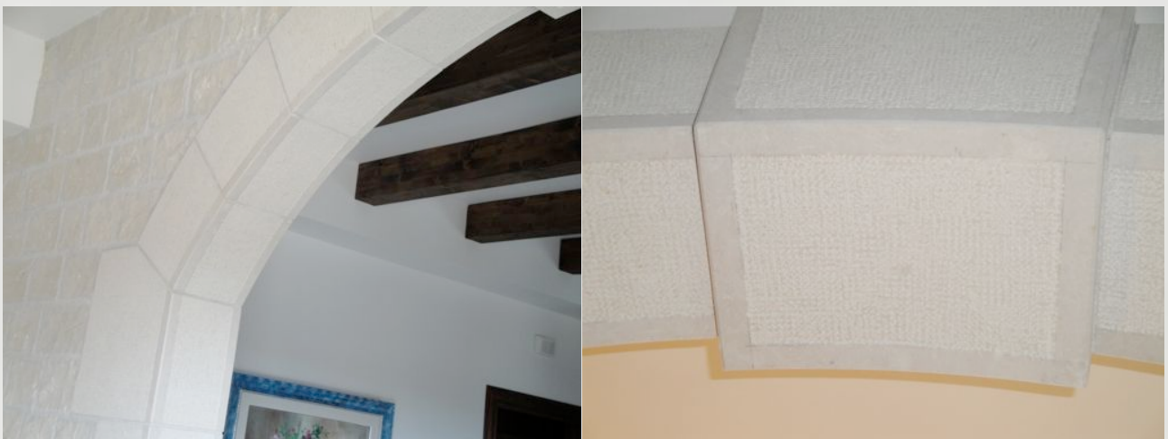
Arco di collegamento fra due stanze eseguito con blocchi massicci lavorati a mano; il resto della parete è stato rivestito con marmette lavorate a spacco di cava. Sotto a destra particolare della chiave di volta.
